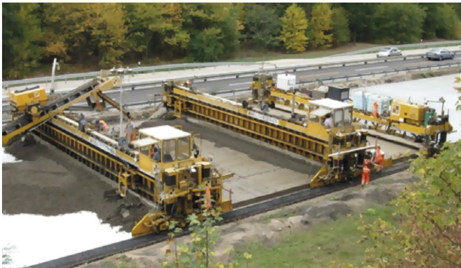
Dvojvrstvé ukládání betonu finišery Heilit+Woerner s kluznými bočnicemi Zdroj: http://grossprojekte.strabag.de/
